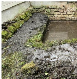
1 er chantier : 7 juin
